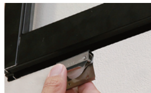
テラス戸・浴室引戸用：9D丸への取替え例
