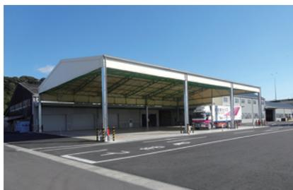
短納期・低コストを両立し、ニーズにも柔軟に対応。膜素材ならではの軽量性を活かし、柱を減らしたゆとりのある設計が可能です。敷地に合わせて変形したテント上屋の提供も可能です。
